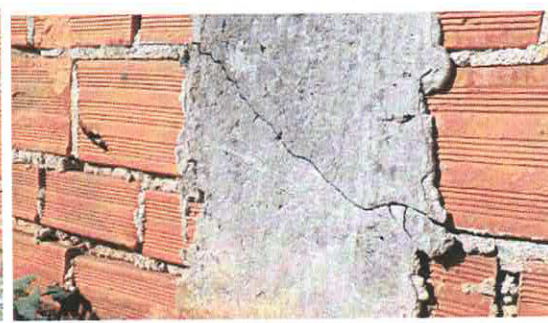
Foto 05: Fissura Coluna Central
