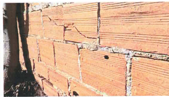
Foto 05: Fissura Coluna Central
