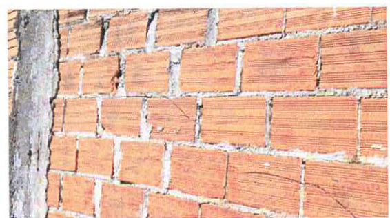
Fotos 06 e 07: Fissuras na Alvenaria
