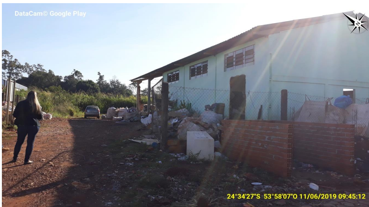
Barracão da associação de catadores de materiais recicláveis.
