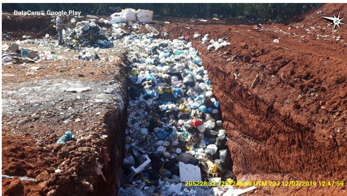
Vala em operação.
