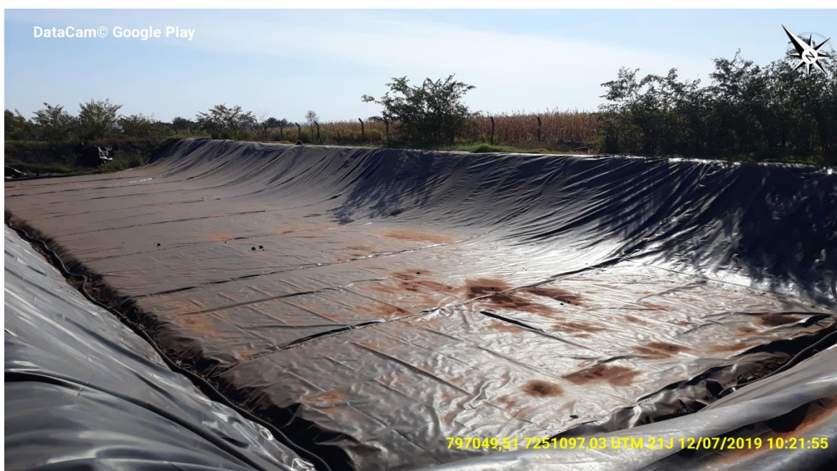
Vala impermeabilizada para disposição dos rejeitos.
