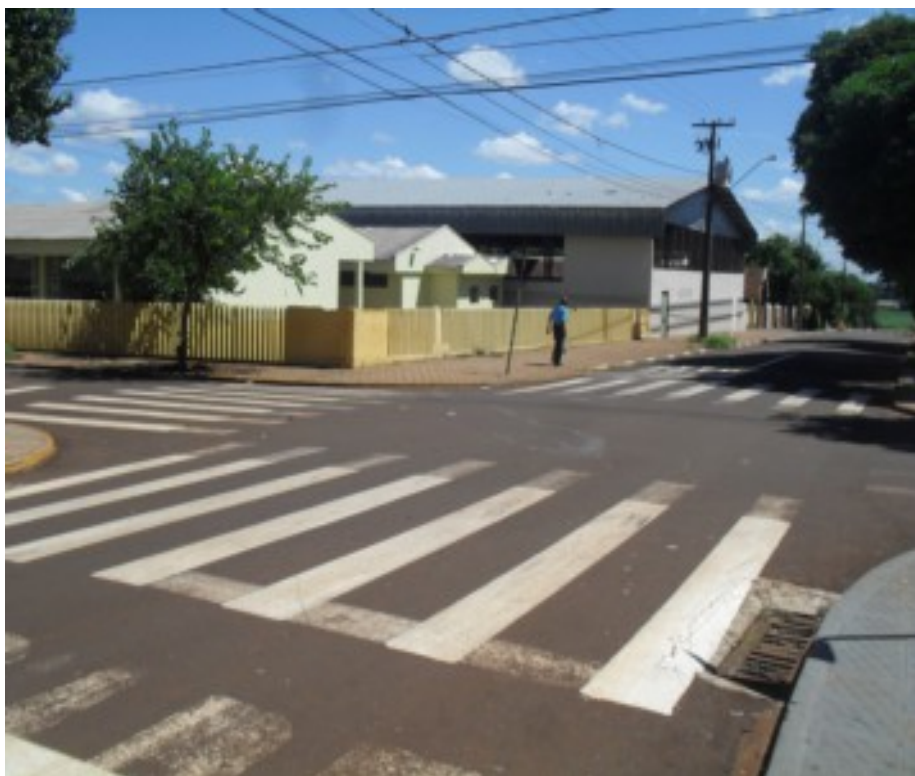
Local da Instalação de Travessia Elevada, nos quatro cantos da Rua Reinaldo Barilli com a Rua Otilia Giaretta, esquina com a Escola Municipal São Francisco de Assis.
