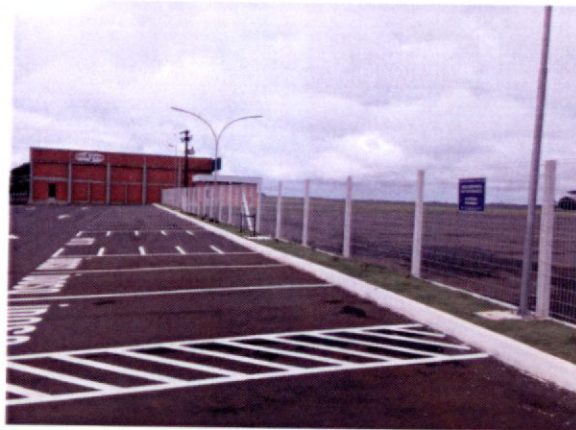
Cerca Patrimonial Próximo ao Terminal de Passageiros, Hangares e Seção Contra Incêndio (Com 2 metros de altura e viga de Concreto)
