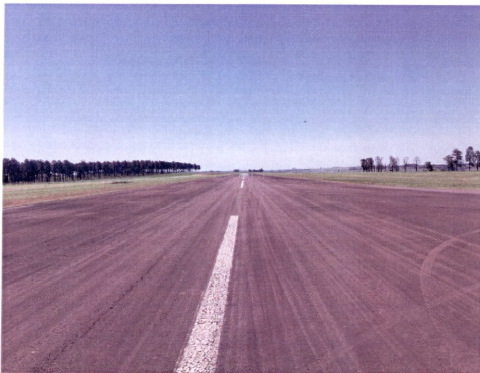
Cabeceira - RWY 20 (Pista de Pousos e Decolagens) – Lado Norte
