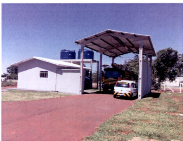
Seção Contra Incêndio - SCI
